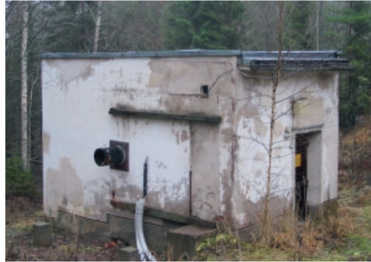
Kuva 1.3 Kellokosken ja Ohtolan sairaaloiden vesilaitoksen vanha pumppuasema, joka oli käytössä vuoteen 2000.
